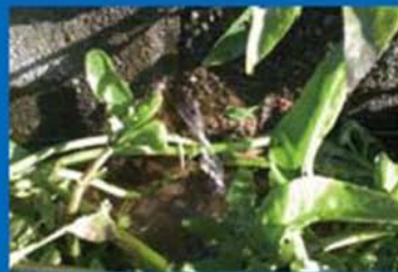
川底やブロックの隙間から水が湧いています
