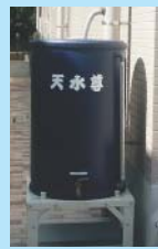
練馬区立春日町リサイクルセンターにある雨水貯水槽(雨水を緑地に散水利用するための貯水槽)
